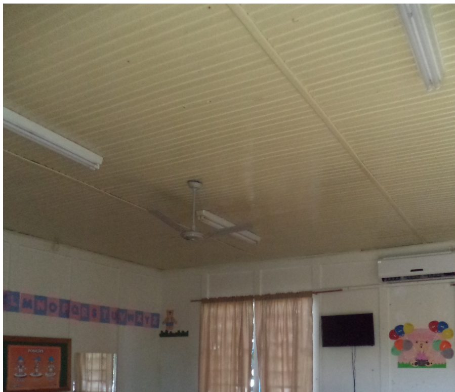
Foto 03 – Forro de madeira em boas condições de conservação (sala de aula)
