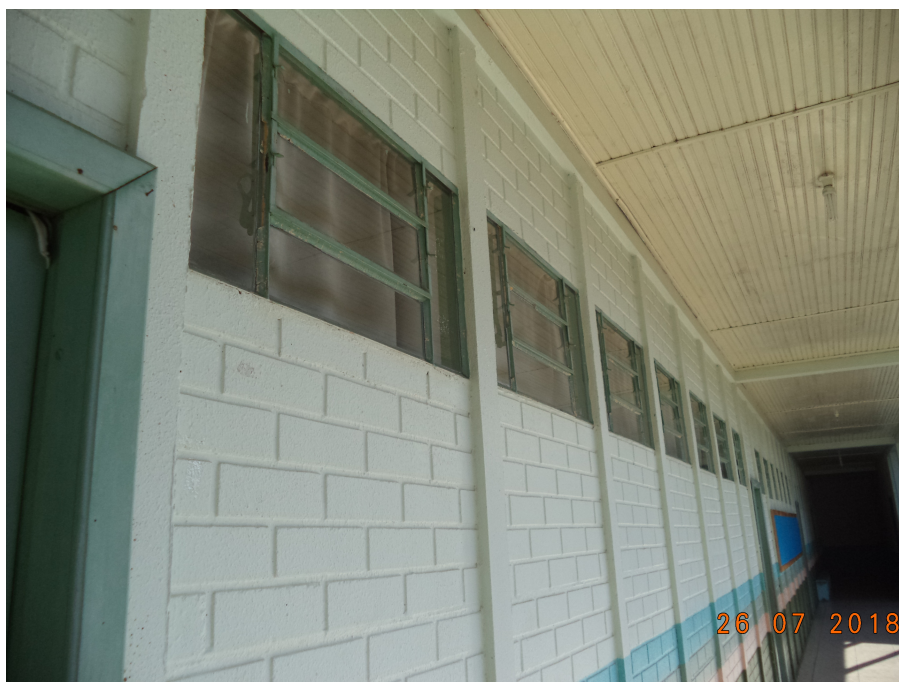
Foto 04 – Esquadrias basculantes em ferro a ser repintadas.
