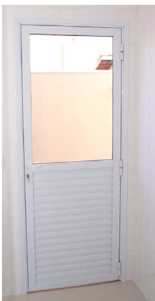
Figura 05 – Porta do depósito de alimentos, acionamento vai e vem.
